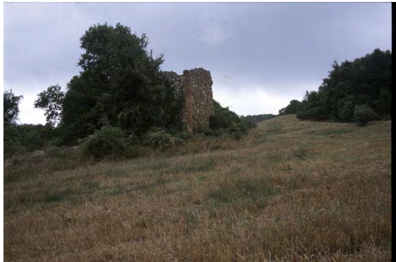
Ruderi del pozzo principale (006b)
