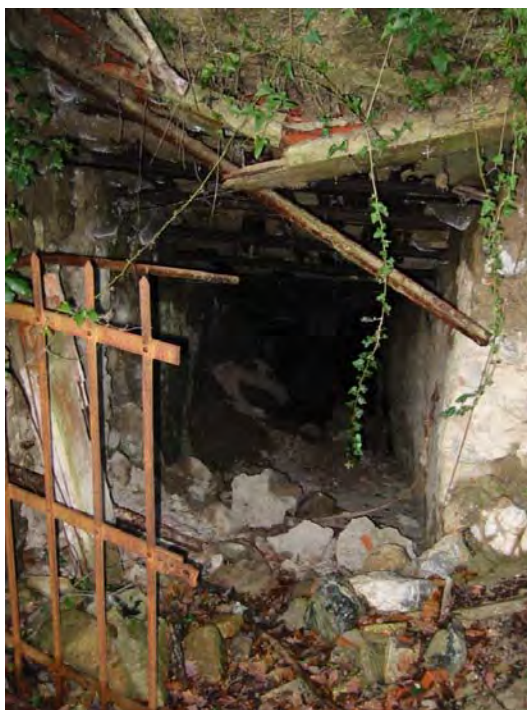
Cava Le Venelle (BPB); ingresso del piano inclinato nuovo
