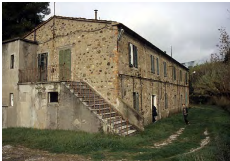
Edificio abbandonato; si notano le tubazioni metalliche esterne dell'impianto di riscaldamento alimentato con i vapori caldi delle fumarole (071a)
