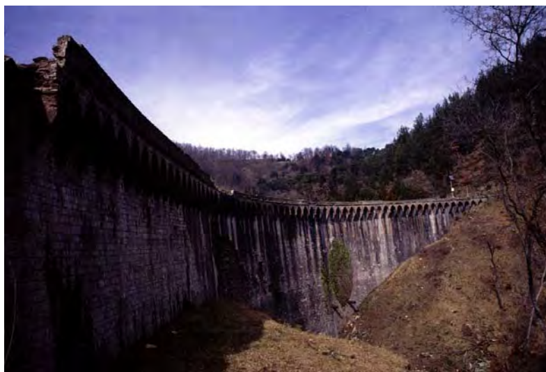
Diga che costituisce il “Margone”; deposito di acqua della laveria della miniera (001g)
