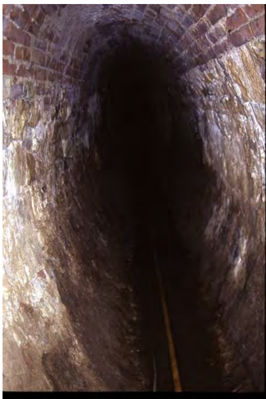
Interno della galleria principale (003a)
