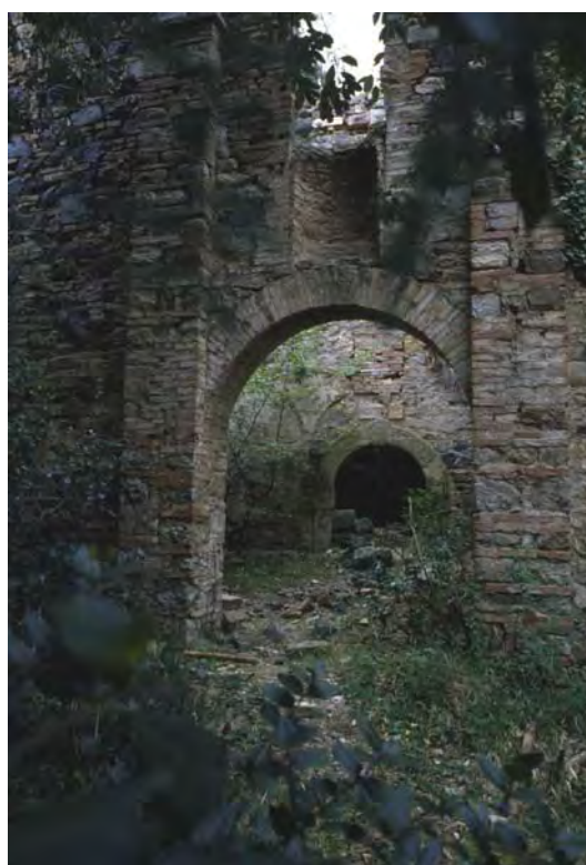
Ingresso della galleria principale nei pressi di Grotta Mugnaioli (005b)
