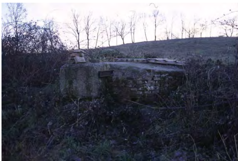
Il pozzo della miniera all'interno del podere Pallareta
