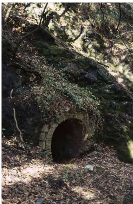
Una delle numerose gallerie di drenaggio (004c)
