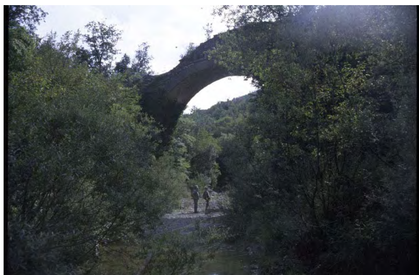
Primo ponte sul torrente Ritasso (104a)
