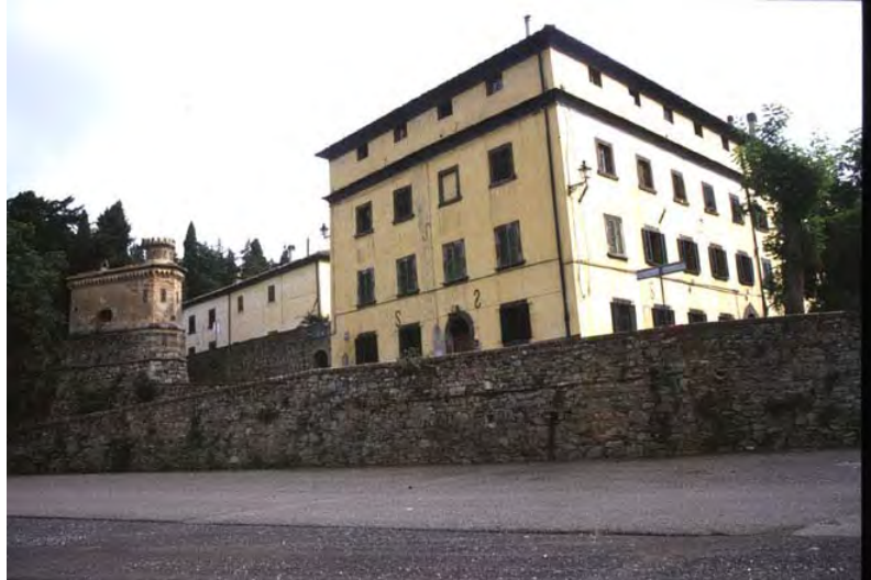
Il grande edificio già sede della direzione della miniera (001c)
