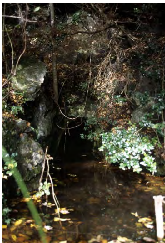
Ingresso della galleria invasa dall'acqua
