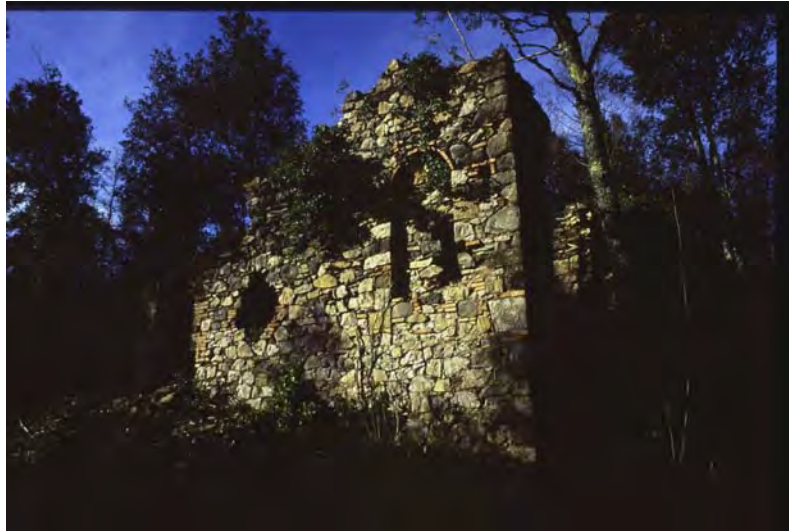
Ruderi di impianti minerari (007a)
