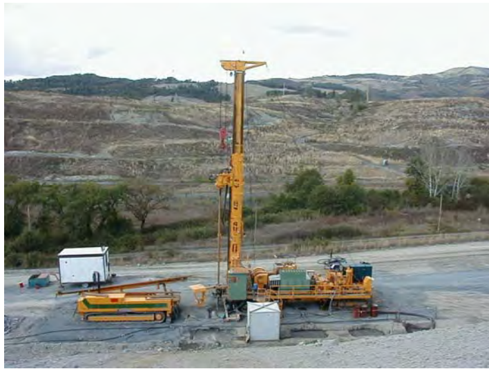
Sonda trivellazione pozzo (foto Solvay)
