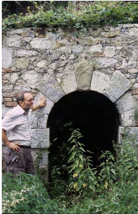
Ingresso della galleria principale (003a)
