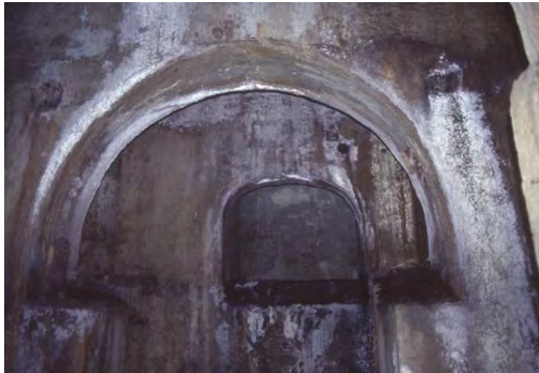
Particolare all'interno della galleria (005b)
