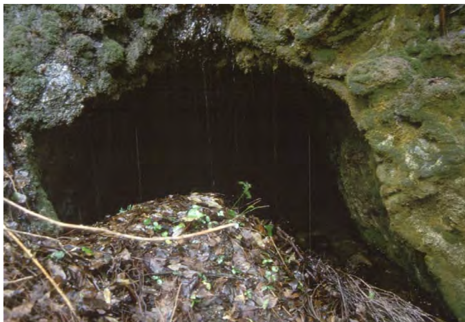
Ingresso della galleria
