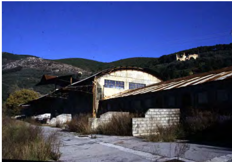
Panoramica degli impianti in stato di abbandono
