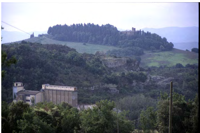
Panoramica della cava e degli impianti
