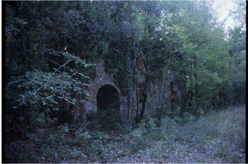
Altro edificio minerario lungo il tracciato ferroviario
