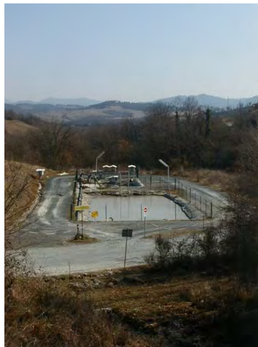
Vasca recupero perdite (foto Solvay)
