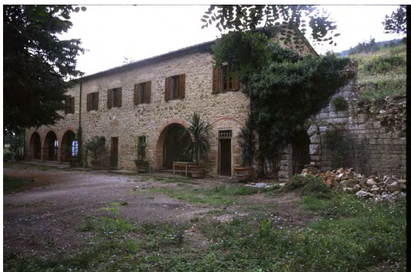
Sulla destra dell'immagine è ben visibile l'ingresso della lunga galleria di scolo detta "Maria Antonia" (001e)
