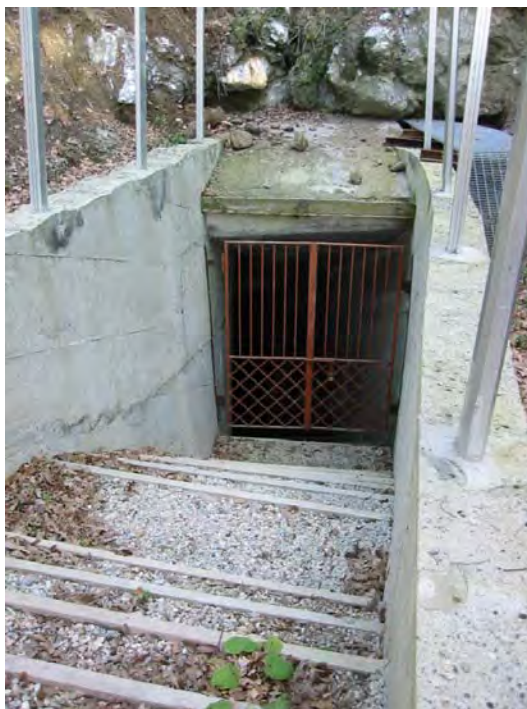
Uscita secondaria e di emergenza della cava “Massetto”; Ecomuseo dell’alabastro (Cava Ostini)
