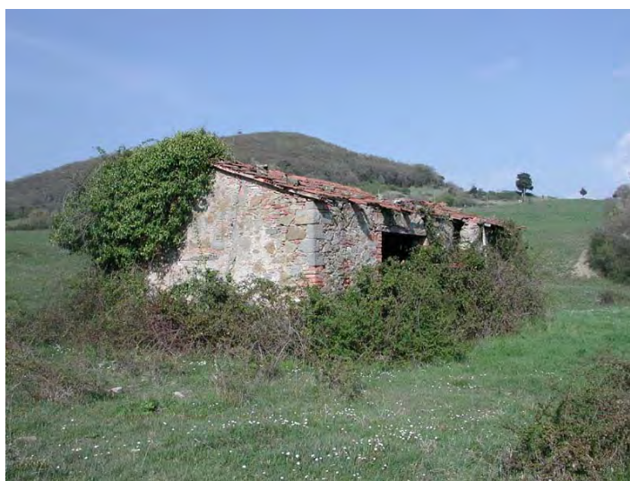
Ruderi dell'edificio minerario
