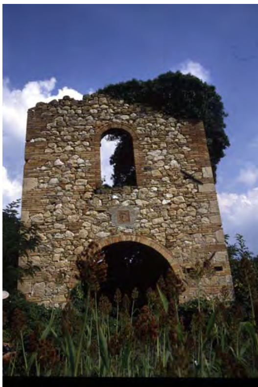
Particolare del pozzo della miniera
