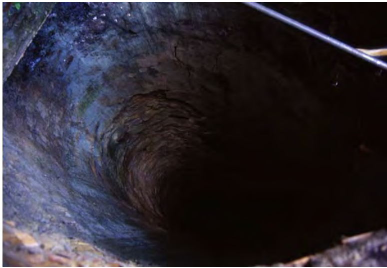
Incrostazioni di ossidati di rame all'interno del pozzo (002a)
