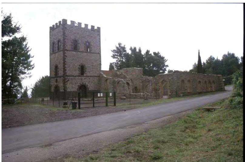
Pozzo "Alfredo" recentemente ristrutturato (001b)
