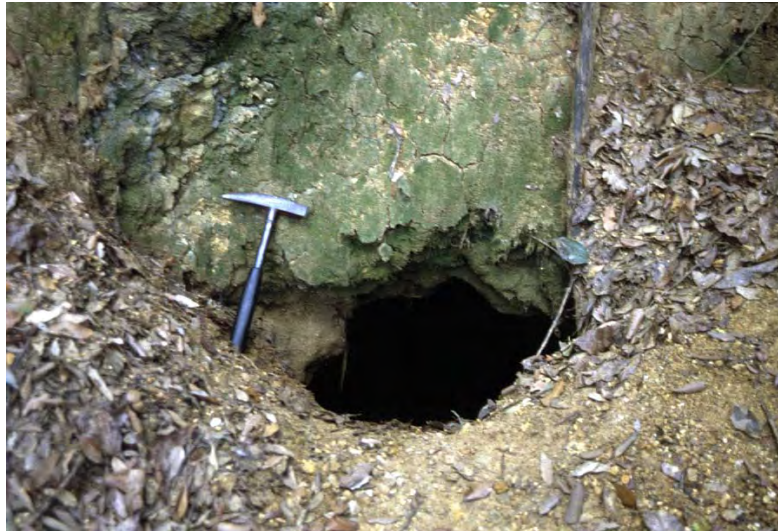
Ingresso della galleria principale quasi del tutto ostruito da smottamenti di terreno
