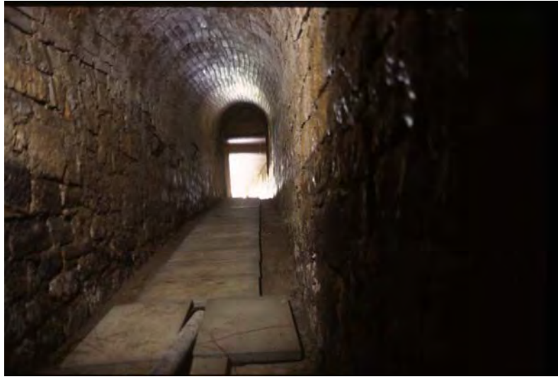
La galleria appena sotto Villa Valentini (003b)
