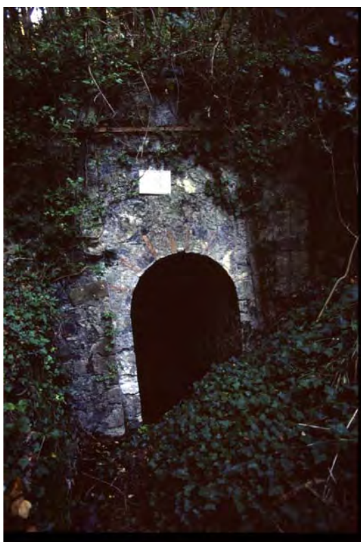
Galleria di scolo situata sulla sponda sinistra del fosso dell'Acqua Calda
